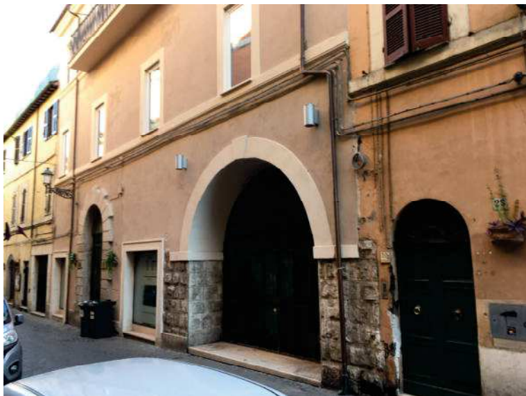
Foto n. 1: vista fabbricato da via Giuseppe Garibaldi
